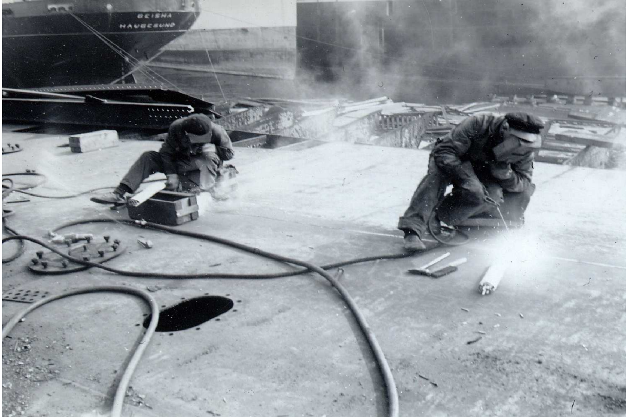
Bild 1. Fartygssvetsare i arbete
